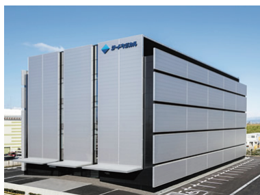
研究中心（2021年11月竣工）
