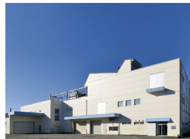
日俣工厂（第一工厂、第二工厂）
